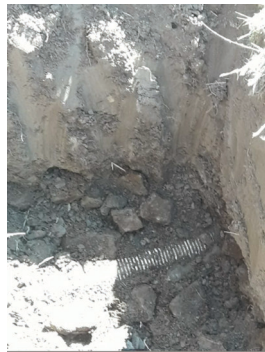
Vue sur un drain (ancien, en bas de T05)
