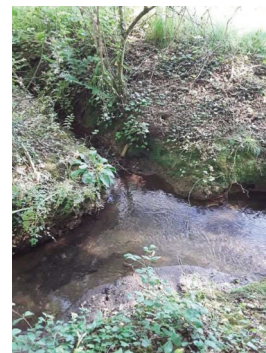
10- Drain en rive droite
