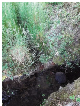
2- Ecoulement provenant du bois humide en rive droite (S1)
